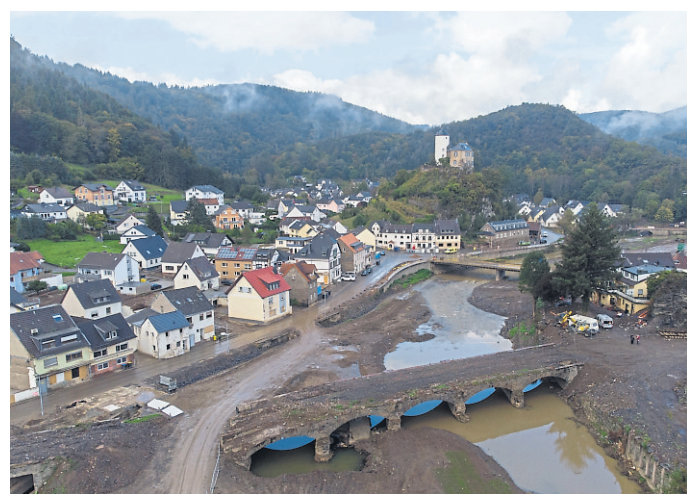
Mittlerweile von Trümmern befreit ist die bei der Flut zerstörte, historische Bogenbrücke über die Ahr in Altenahr-Kreuzberg. Foto: dpa
